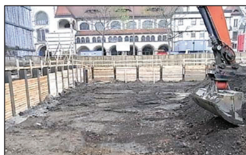
Abb. 4. Schichtenweiser Abtrag, verpflichtend bei baubegleitender KMR
